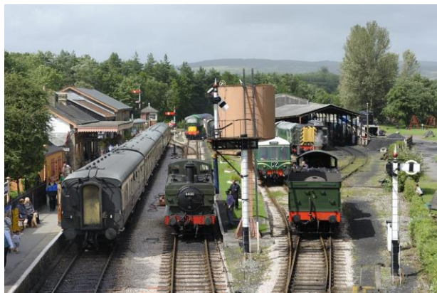
Bahnhof Buckfastleigh. Hier endet die South Devon Railway.
