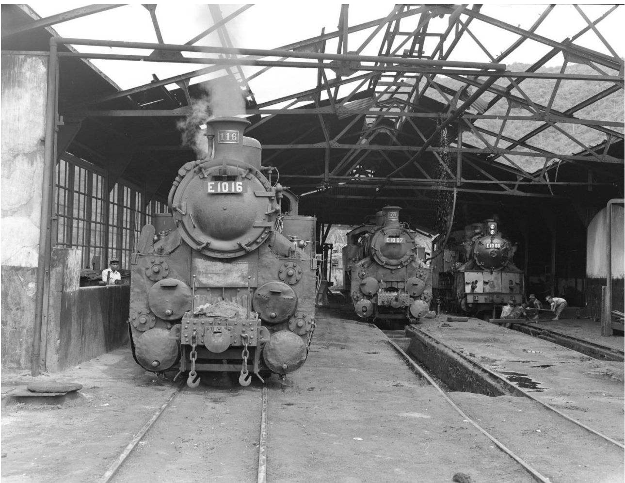
Depot der Zahnradbahn Padang – Sawah Loento in Indonesien. Die E 10 07 (Mitte) kommt aus Winterthur, die E 10 16 (links) und die E 10 60 (rechts hinten) sind in der Maschinenfabrik Esslingen entstanden. Sommer 1979.
