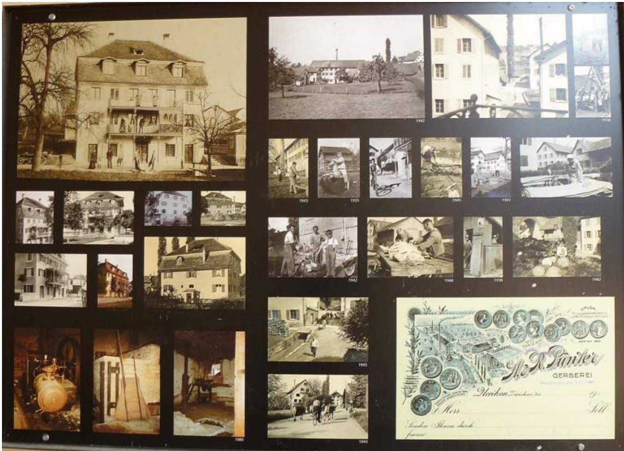
Erinnerungstafel an die frühere Gerberei beim ehemaligen Maschinenhaus in Uerikon
